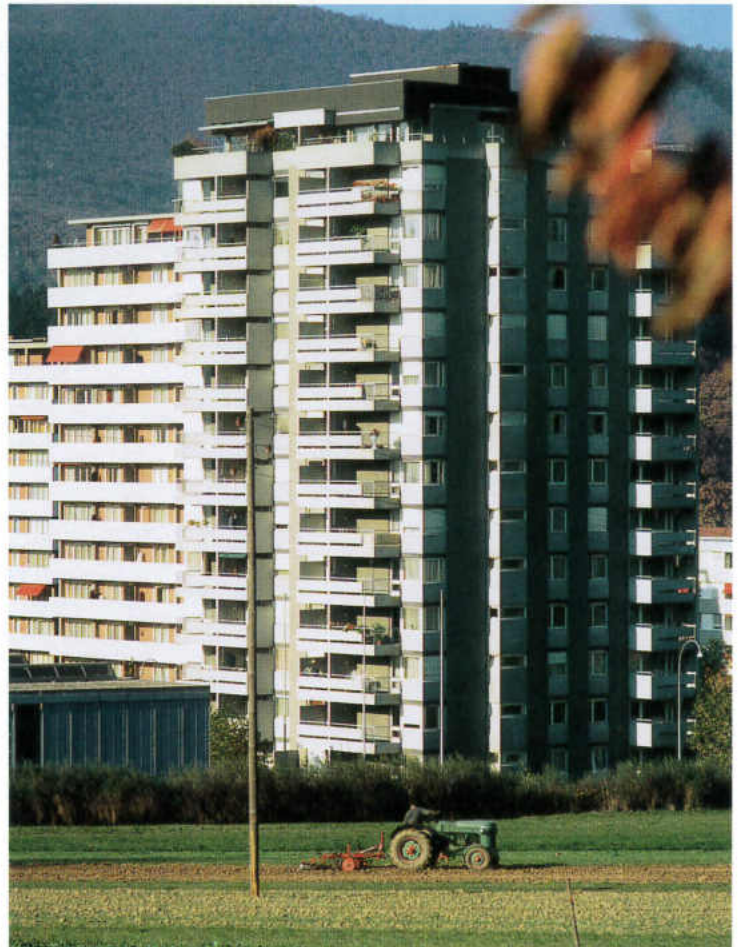
Die drei Hochhäuser dominieren das Bild im Wilerfeld.
