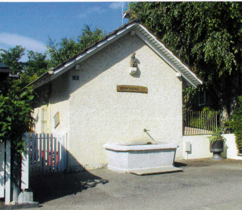
Im «Wöschhüsli» an der Unteren Hardegg wuschen die Bewohner der 12 Doppelfamilienhäuser ihre Wäsche. Hier holten sie auch das Trinkwasser, denn die einfachen Häuser waren ohne Wasseranschluss. Der Brunnen trägt die Jahreszahl 1868.
