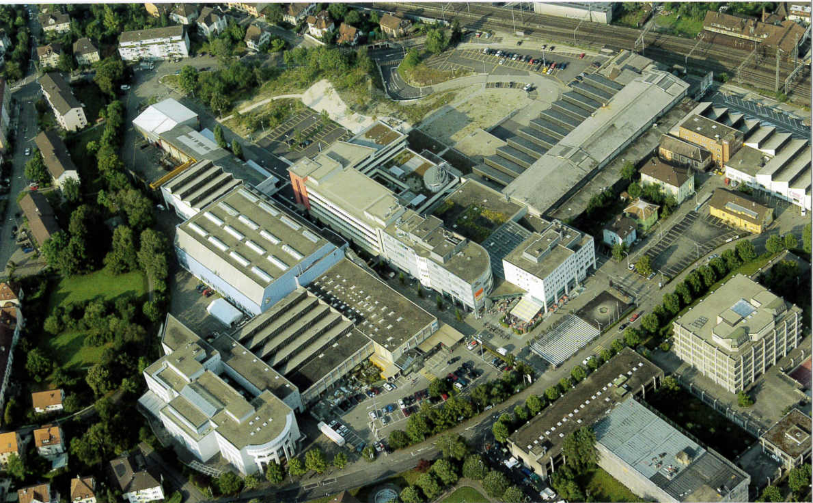
Auf dem Gelände der Giroud-Olma AG entstand in den letzten Jahren das grösste Einkaufszentrum auf Oltner Boden, der «Sälipark» mit 28 Geschäften. Im Zentrum der Flugaufnahme der «Sälipark» mit dem Hotel Arte und der Klinik Pallas.
